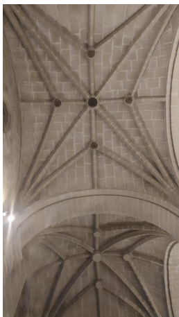
bóvedas de crucería
