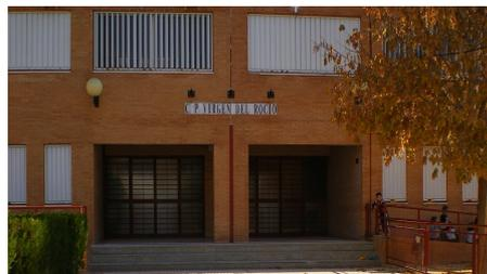
Fotografía de las puertas de la antigua entrada principal del centro por la c/ San Juan de Aznalfarache donde se aprecian las partes fijas y móviles y el acristalamiento total de la puerta así como la falta de rejas de protección contra los robos.
