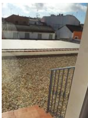
Cubierta Primera Planta
