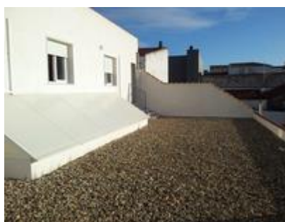
Cubierta Primera Planta
