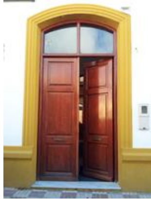
Puerta Única Acceso al Centro
