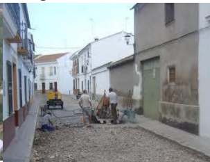
Alcantarillado y pavimentación
