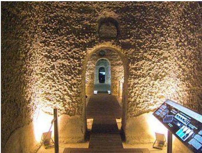
Vista del interior de las cisternas romanas conservadas en Monturque.
