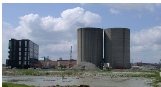
Proyecto Frosilo de MVRDV – Antes de la rehabilitacion
