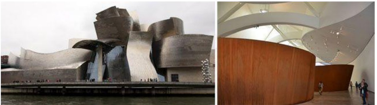
Museo Guggenheim de Bilbao – Frank Gehry – Fuente: Plataforma Arquitectura
