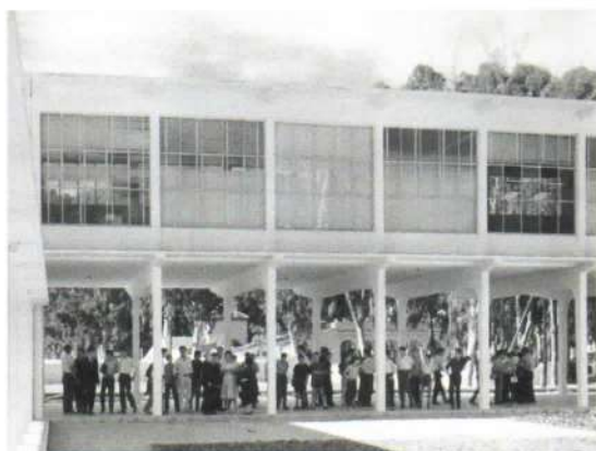
Fig. 7. Detalle de los ventanales de las aulas. Para acceder a las aulas de esta última foto habría que subir las escaleras de la foto anterior y girar el pasillo a la izquierda. Instituto Andaluz del Patrimonio Histórico, bajo Licencia Creative Commons
