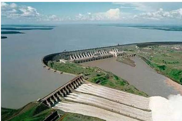
b) **Centrales hidroeléctricas:** generan una potencia superior a los 10 MW. Se sitúan en ríos caudalosos. Las grandes tienen una potencia instalada enorme, como la de Itaipú (Paraguay-Brasil) de 14 GW o la presa de las tres gargantas (China) con 22,5 GW.
