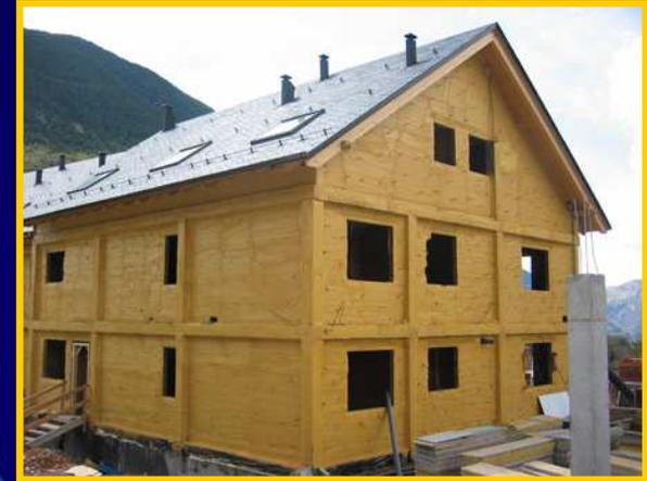
← **Planchas de espuma de poliestireno extruida:** como aislamiento térmico.
