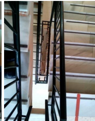
Hueco de escaleras
