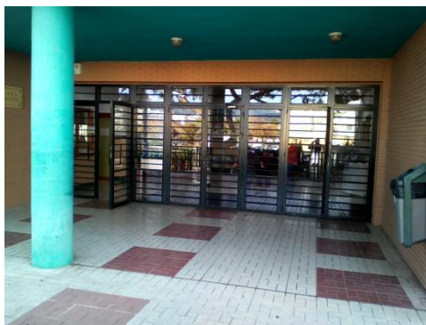
Puerta principal al edificio
