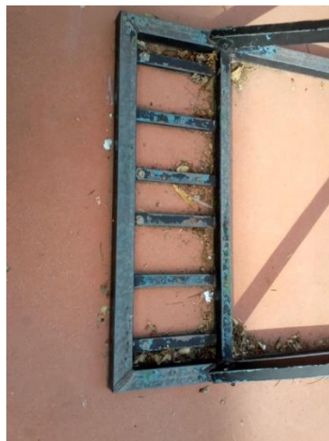
Anclajes de canastas
