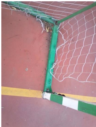
Anclajes de porterías
