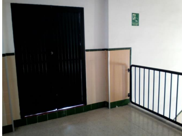
Puerta de acceso al tejado
