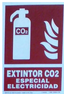
Indicación de cuadro eléctrico y extintor
