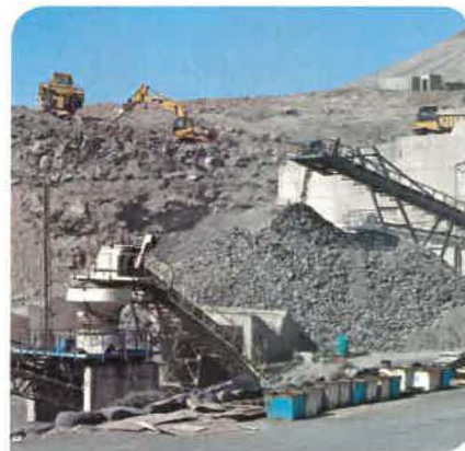
Gravera de extracción de áridos.
