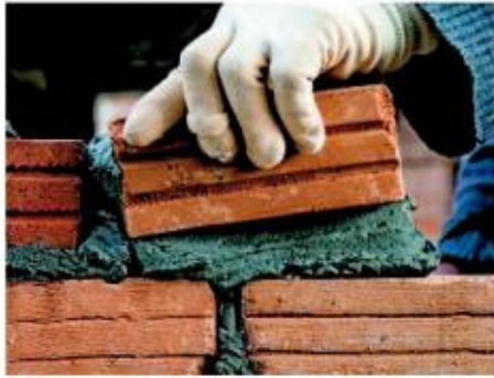
Mortero para unir ladrillos
