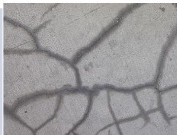
Grietas tapadas con cemento.
