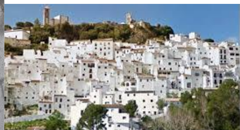
FACHADAS DE CAL
