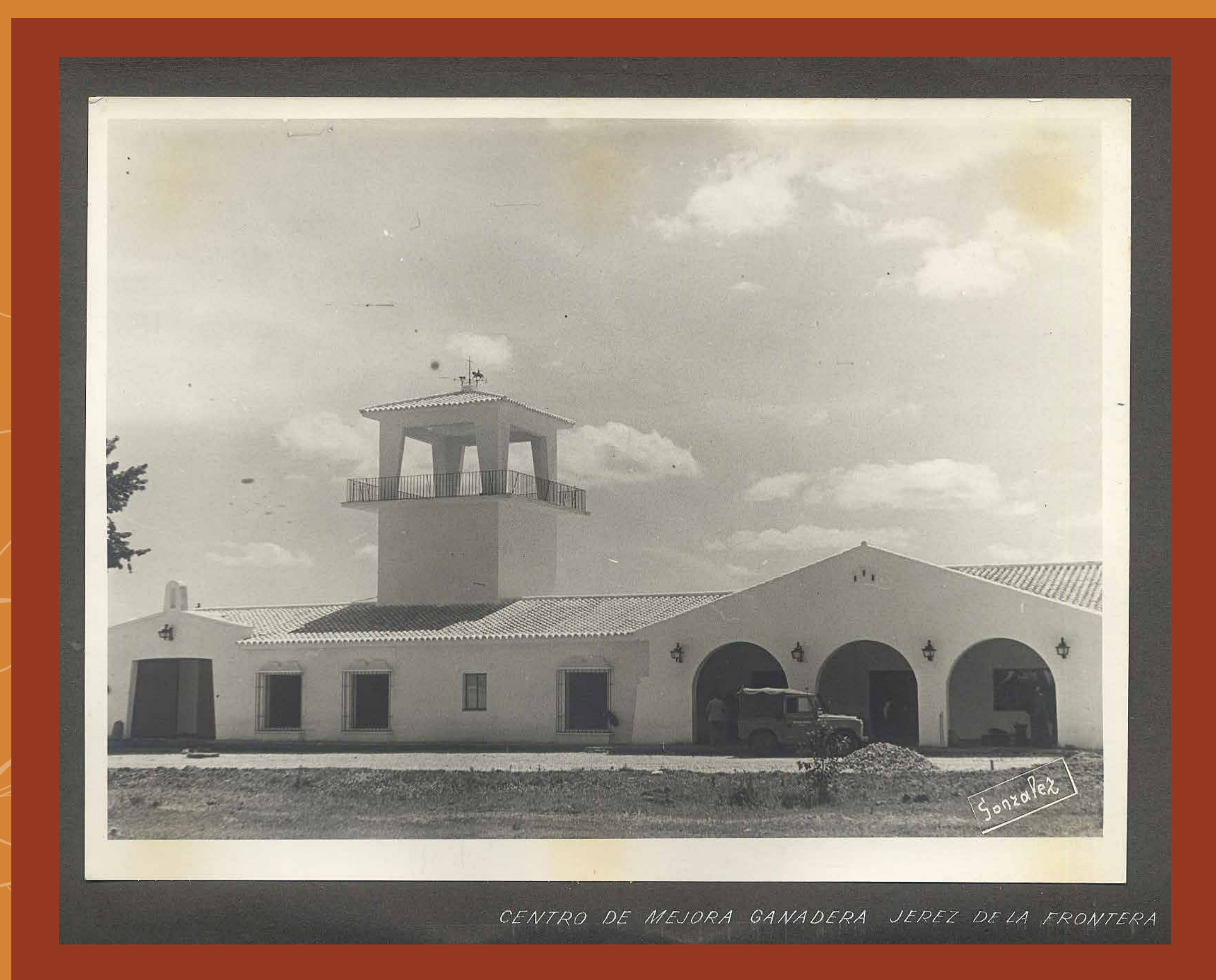
Centro de Mejora Ganadera (Hoy Parte Antigua del instituto)
