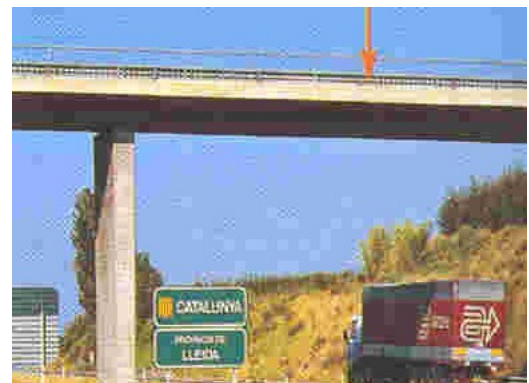
Puente de vigas
