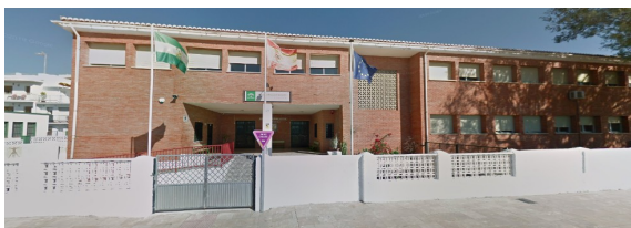
Figura 2: Edificio principal (antiguo colegio EGB)
