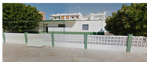
Figura 1: Edificio anexo (antiguo colegio infantil)
