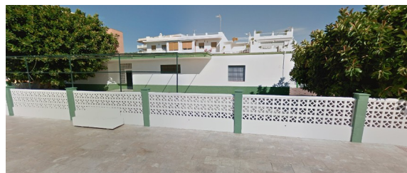
Figura 1: Edificio anexo (antiguo colegio infantil)
