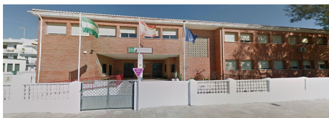
Figura 2: Edificio principal (antiguo colegio EGB)
