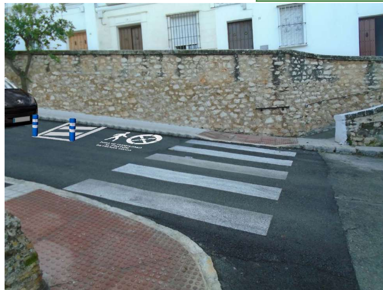
Montaje con instalación de marcas viales.
