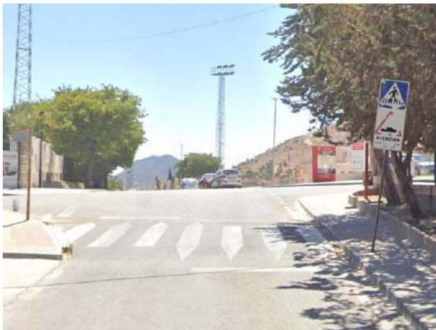
Señalización vertical desgastada relativa a paso para peatones junto a centro educativo, en avenida España.
