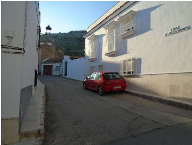
Ausencia de rebaje en paso peatonal propuesto en calle Los Almendros.
