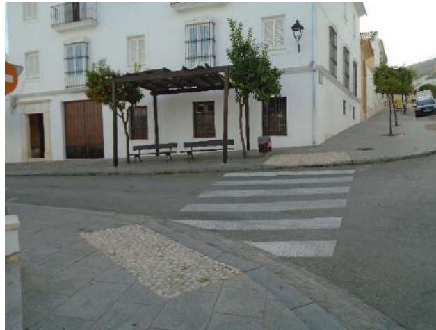
Necesidad de rebaje en paso para peatones en plaza del Llanete.
