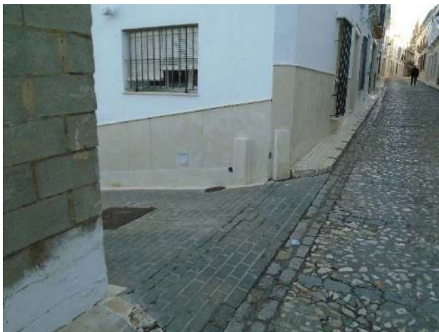
Ausencia de marcas viales de paso para peatones en calle Atahona, intersección con calle Hornillos.
