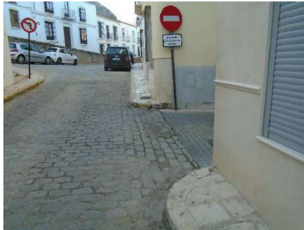
Ausencia de paso para peatones y de rebaje en acera en calle Vinagre, intersección con calle Cardenal Spínola.
