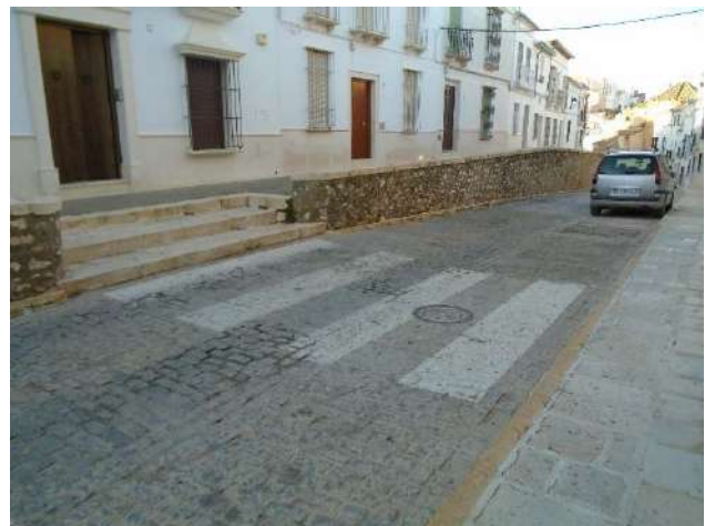
Necesidad de rebaje en paso peatonal en calle Veracruz.
