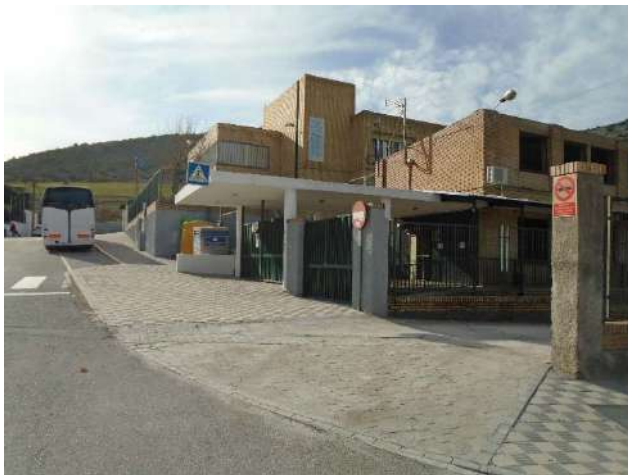
Acceso al centro educativo en avda. España, en intersección con carretera Becerrero.
