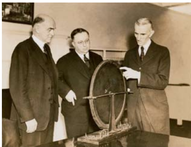
En la foto, de izquierda a derecha: Víctor Beam, su secretario y Nikola Tesla alrededor del alternador que Beam encontró en el almacén de la empresa Westinghouse. El alternador fue salvado del incendio en el laboratorio que estalló el 13 de marzo de 1895.
